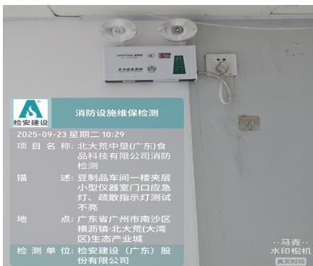
142. 小型仪器室门口应急灯、疏散指示灯测试不亮。
