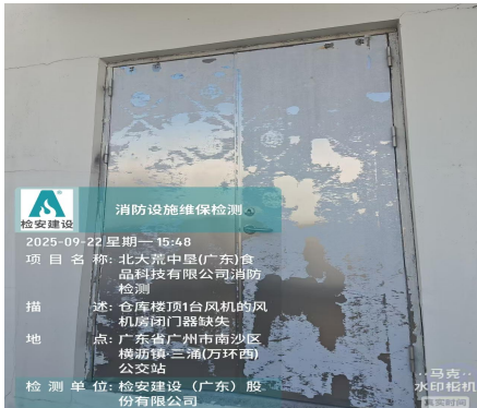
71. 1 台风机的风机房防火门闭门器缺失。
