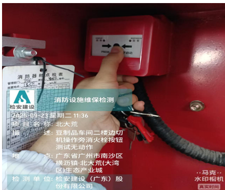
137. 边切机操作旁消火栓按钮测试无动作。
