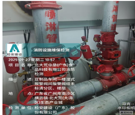
150. 湿式报警阀间进门第二个报警阀组DN20过滤阀损坏。
