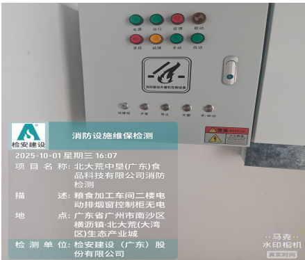
202. 粮食加工车间二楼电动排烟窗控制柜无电。
