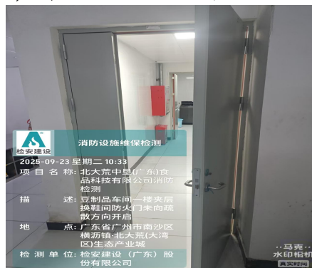
140. 换鞋间防火门闭门器缺失，未按疏散方向开启。
