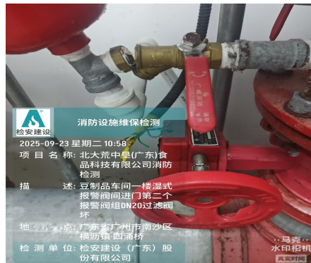
150. 湿式报警阀间进门第二个报警阀组DN20过滤阀损坏。
