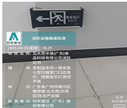
142. 小型仪器室门口应急灯、疏散指示灯测试不亮。
