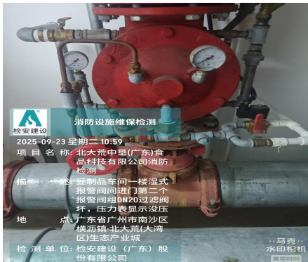
150. 湿式报警阀间进门第二个报警阀组DN20过滤阀损坏。
