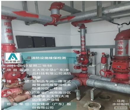
150. 湿式报警阀间进门第二个报警阀组DN20过滤阀损坏。
